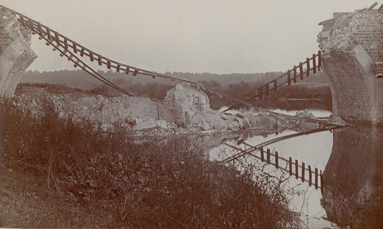
Vue d'ensemble de la brèche côté aval.
