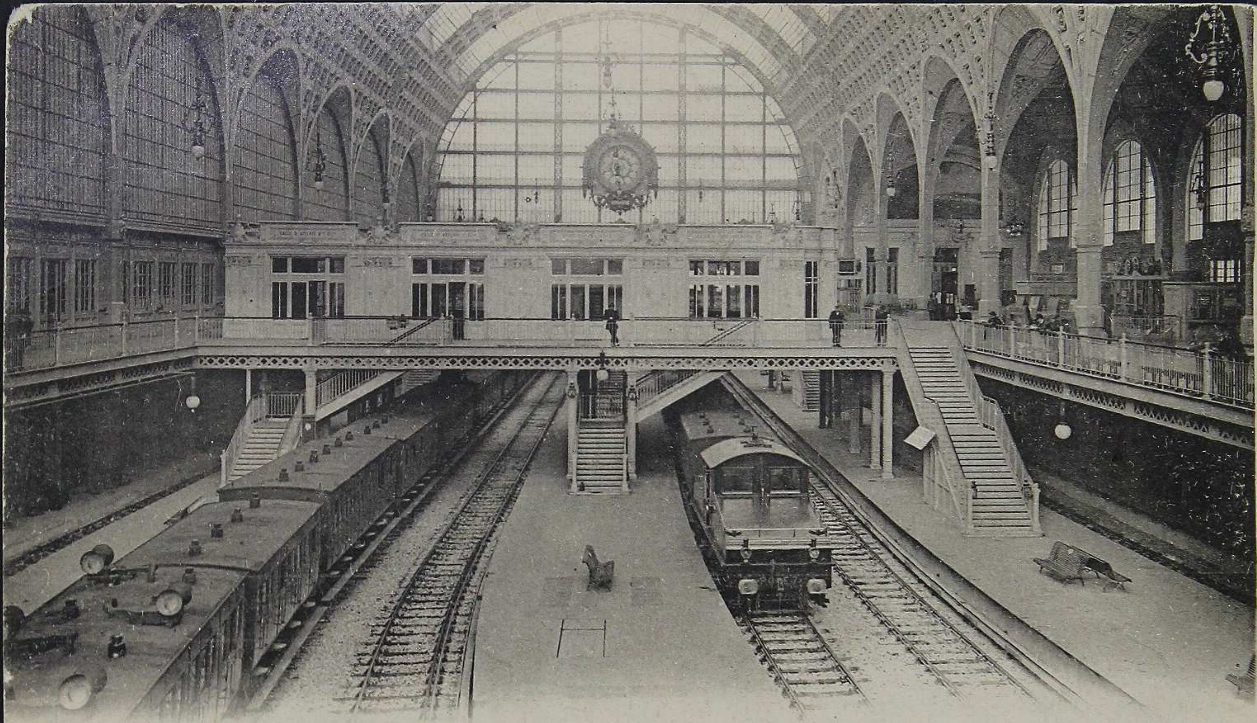
152 PARIS. — Intérieur de la Nouvelle Gare d'Orléans. - LL.
